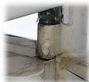
Traces de graisse sur la charnière supérieure
